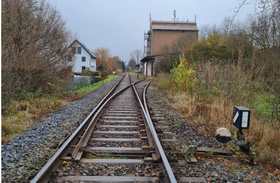
**Abbildung 8: noch angeschlossene, aber nicht mehr aktive Gleisanschlüsse (hier Schweinsberg-Raiffeisenlager), können mit überschaubarem Aufwand wieder reaktiviert werden**
